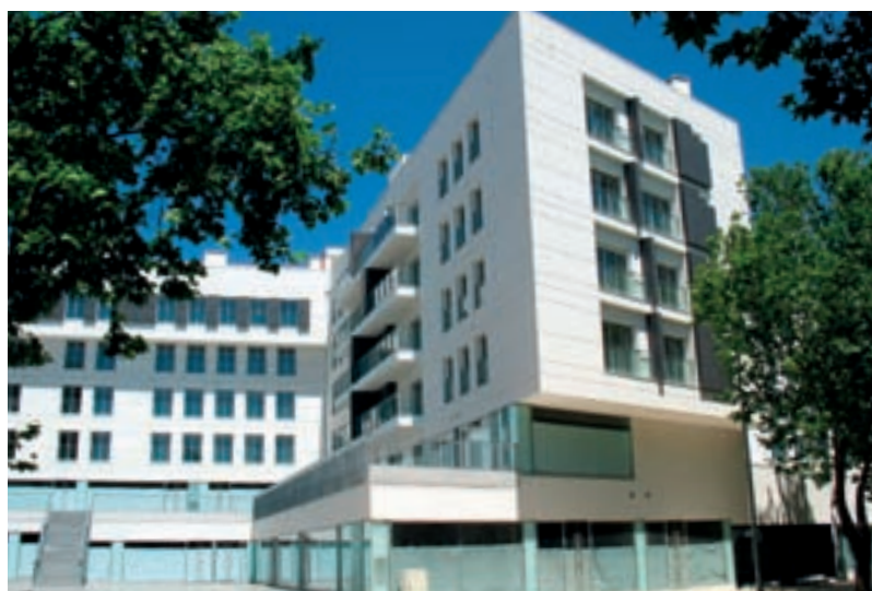
Revestimento exterior de edifício habitacional
