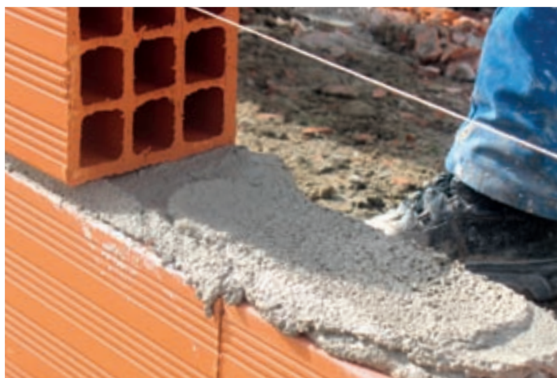
Elevação de pano em alvenaria
