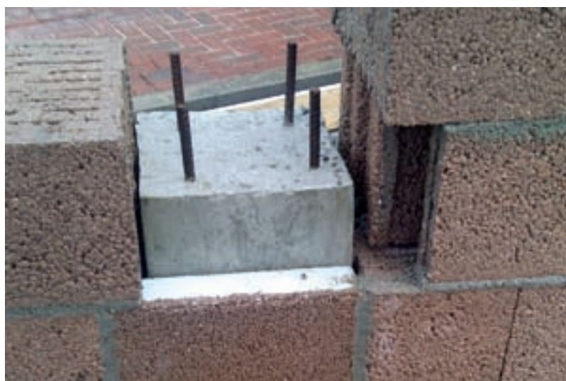
Aplicação da ALVENARIA ecoCORK
