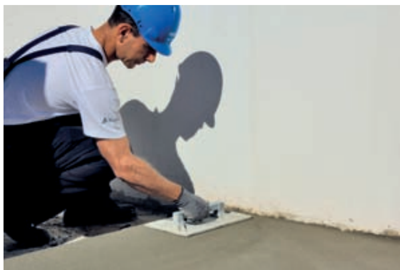
Aplicação da BETONILHA ecoCORK
