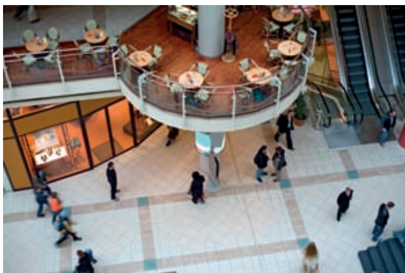
Revestimento cerâmico em zona de tráfego intenso
