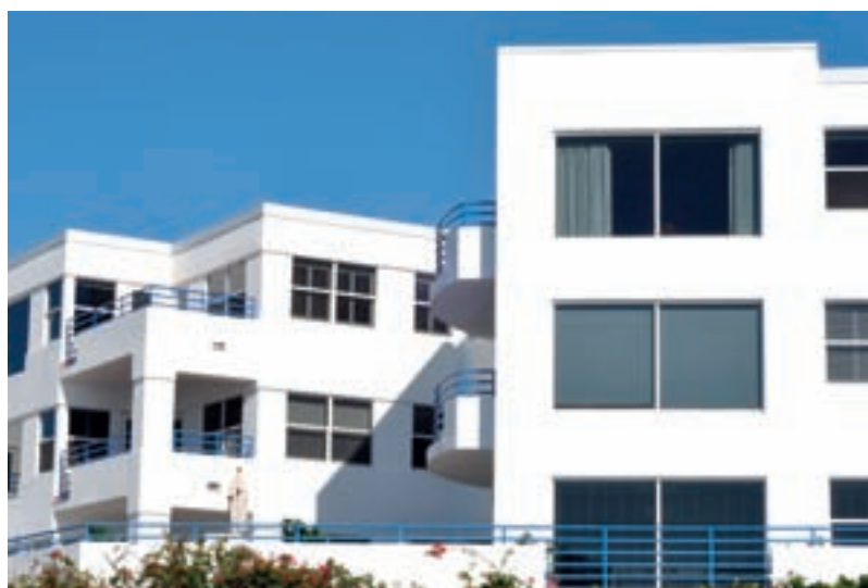
Revestimento branco exterior em edifício habitacional
