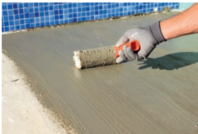
Impermeabilização de piscina
