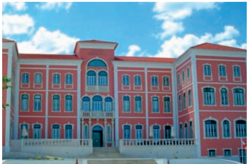
Fachada de edifício histórico renovada
