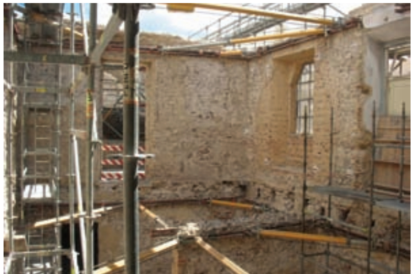
Injeção de calda em parede antiga
