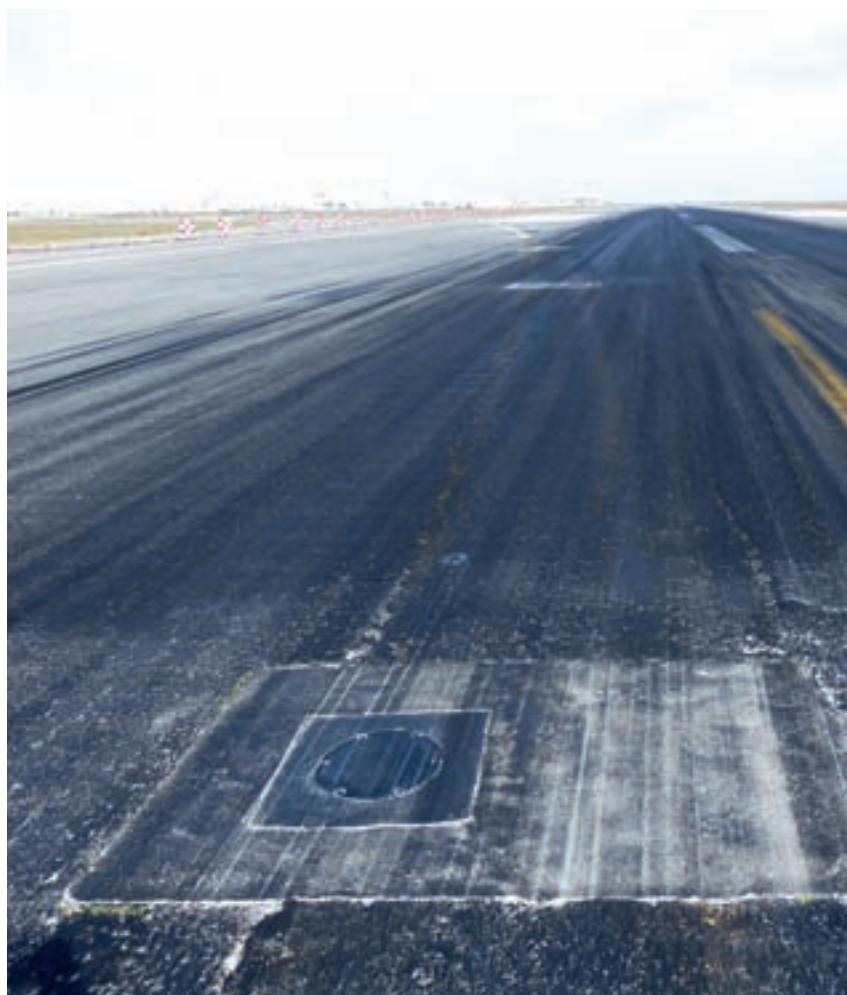
Aeroporto de Faro – Fixação dos sistemas de iluminação na pista
