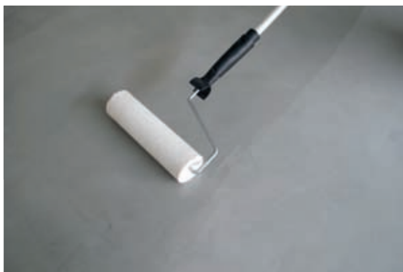
Aplicação de verniz em microcimento
