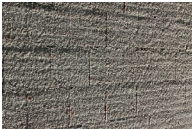
Preparação de suporte com REDUR Fix
