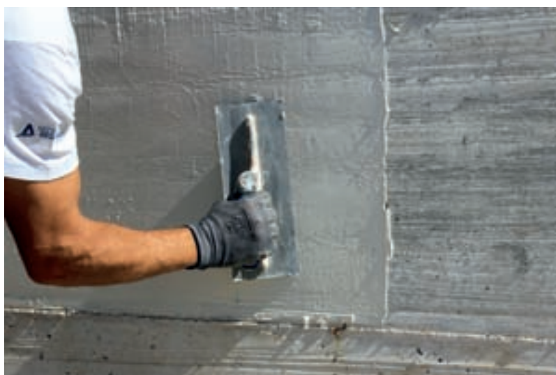
Reparação estética de betão arquitectónico
