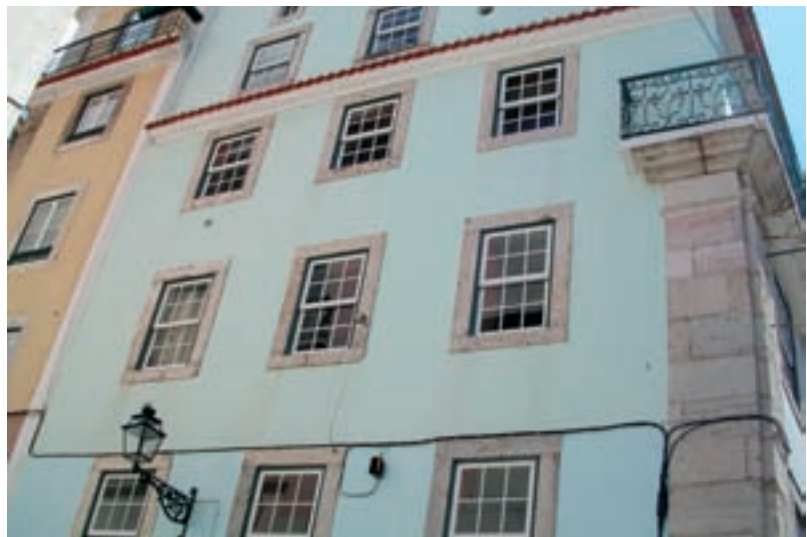
Edifício na Rua do Loreto em Lisboa
