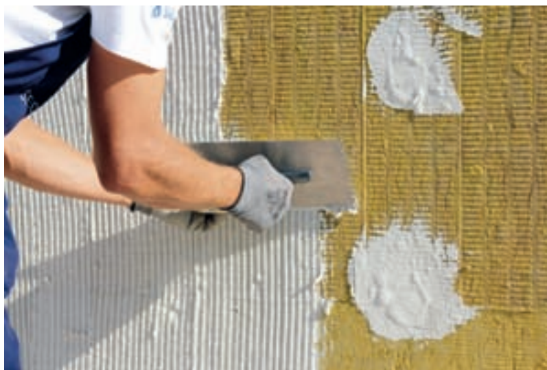
Aplicação de ADHERE Vit FibrasFLEX
