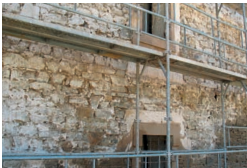
Reabilitação de alvenaria antigas com humidades ascensionais
