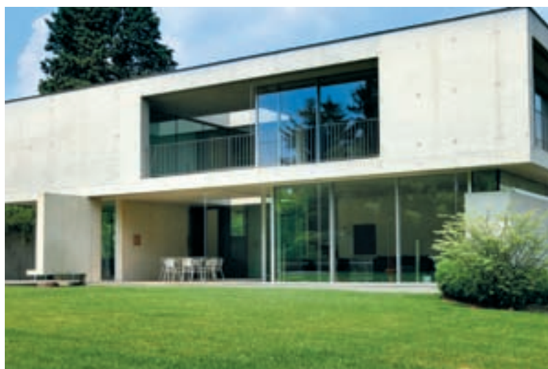
Elemento arquitectónico em betão branco
