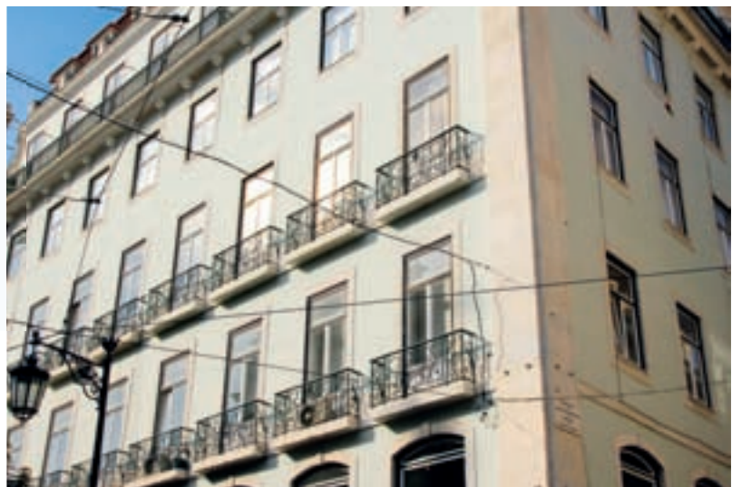
Revestimento exterior liso em edifício habitacional
