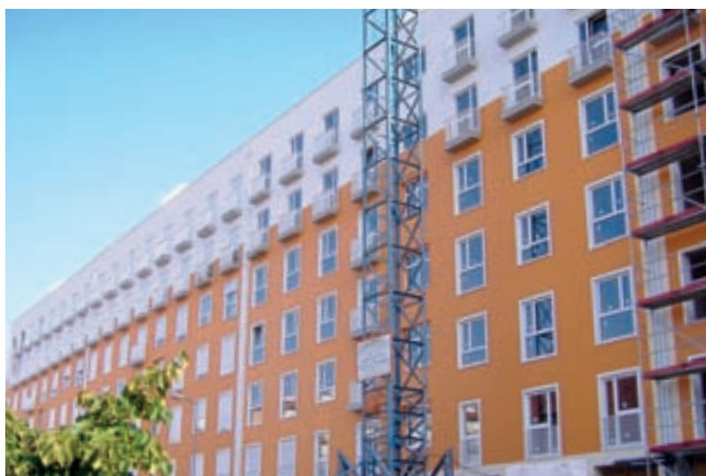
Revestimento exterior em edifício habitacional
