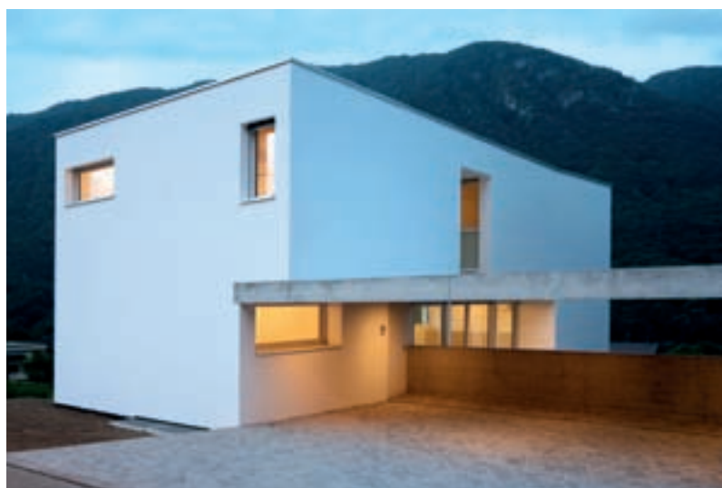
Revestimento de moradia com acabamento areado fino
