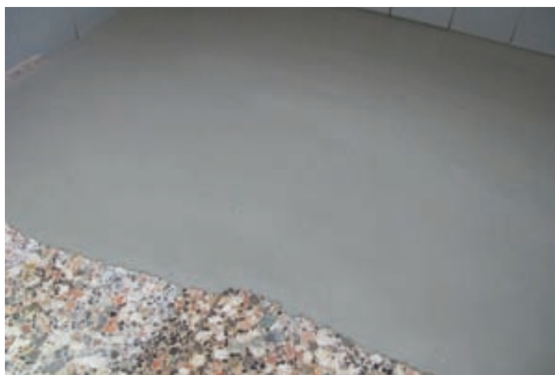
Aplicação de autonivelante em renovação
