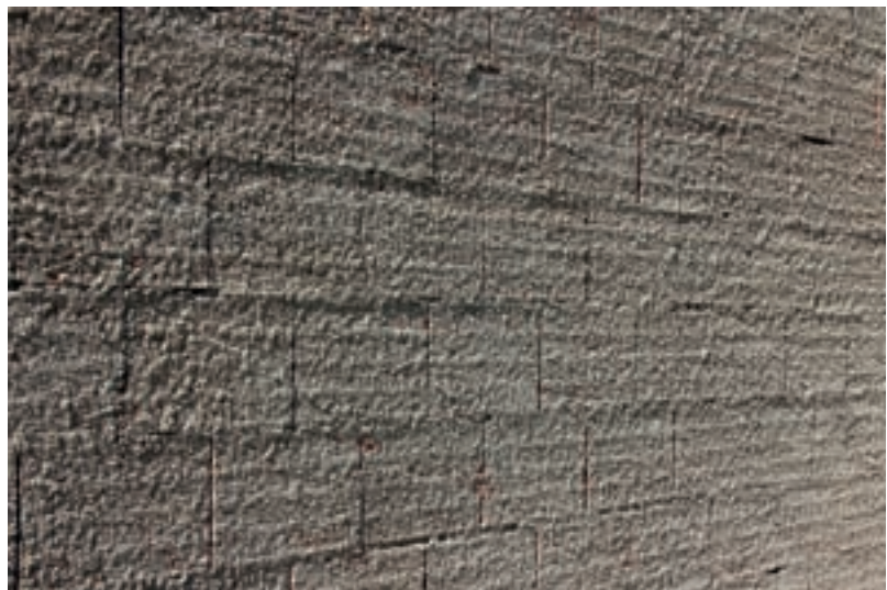
Preparação de suporte com ARGAMASSA DE CHAPISCO
