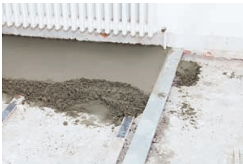
Aplicação de betonilha
