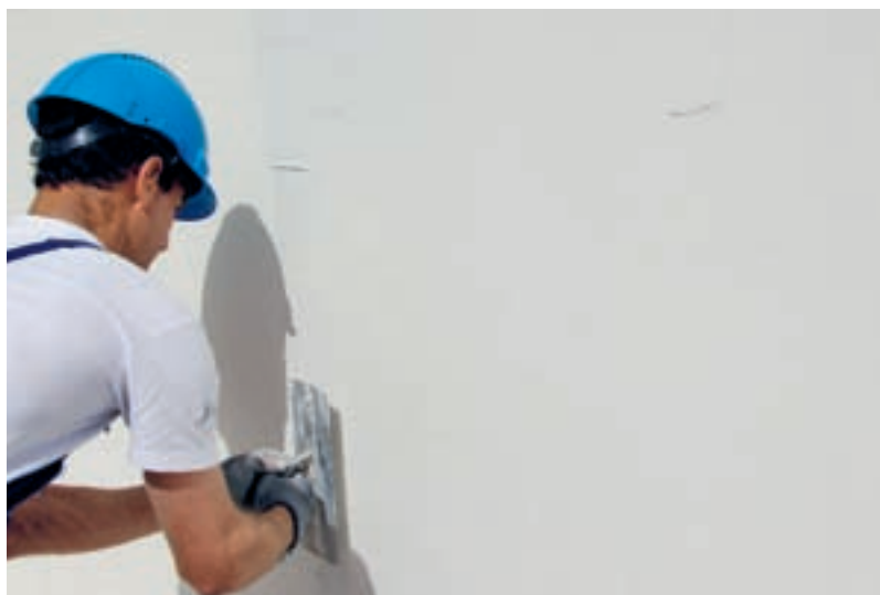
Aplicação em obra de FIXDUR
