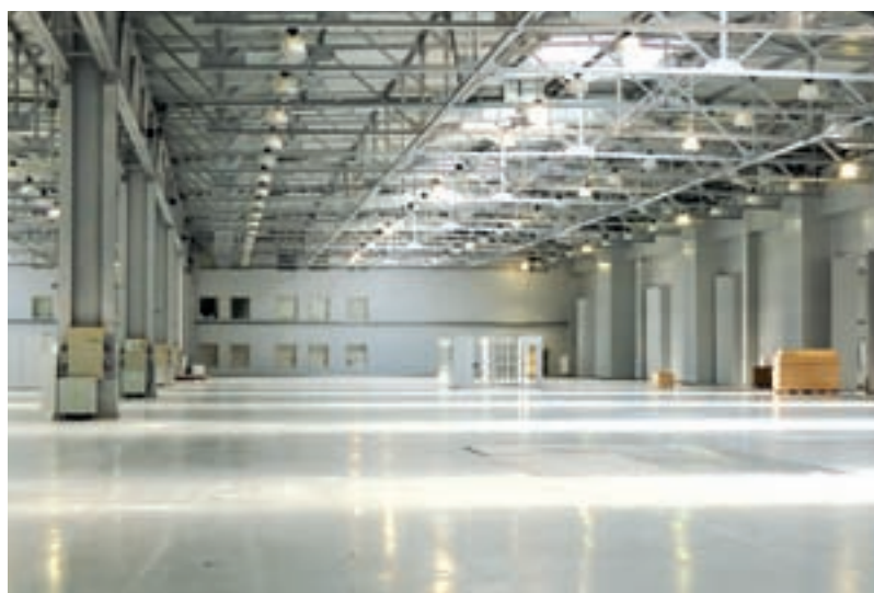
Pavimento de elevado desempenho em armazém
