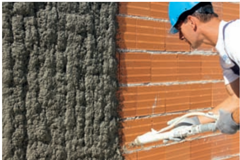
Proiecção de elevado rendimento do Reboco ecoCORK
