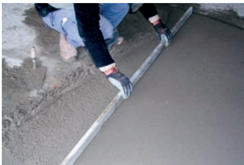
Regularização da BETONILHA
