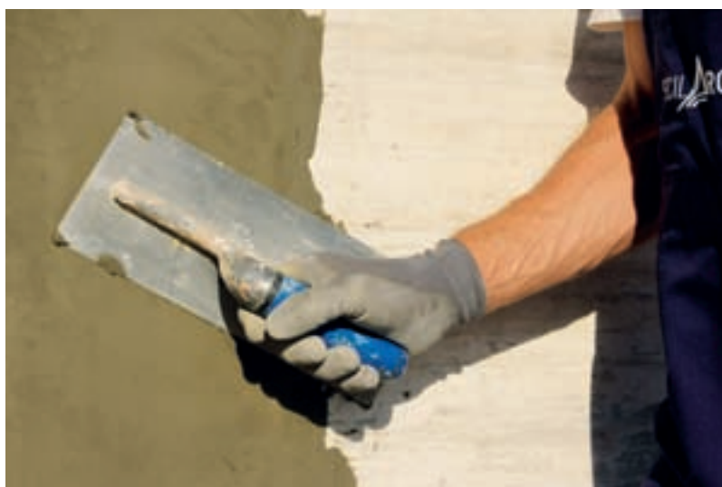
Impermeabilização de tanque em betão
