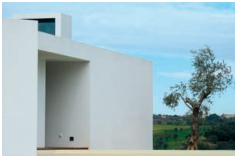
Acabamento decorativo acrílico REVDUR em moradia
