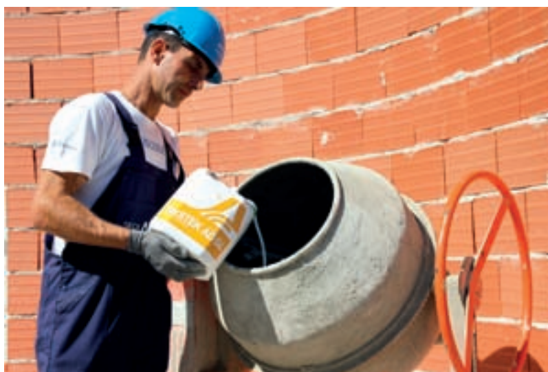
Preparação de argamassa com SecilTEK AD 04
