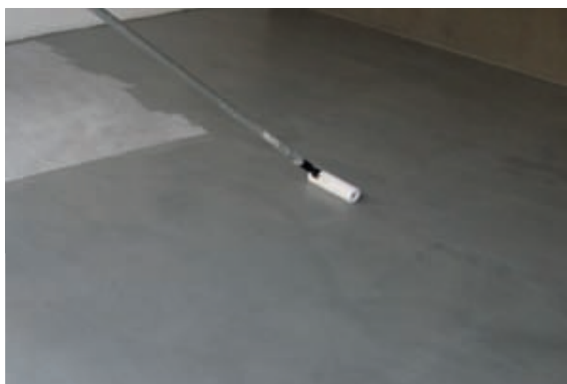
Aplicação de SecilTEK AD 91 sobre Microcimento SECIL
